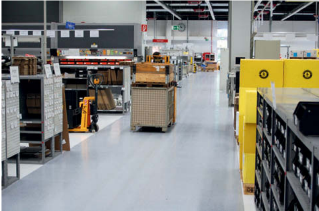
Płytki Colorex ułożone na drogach transportowych
